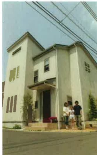
スリット状の窓を採用するなど、プライバシーにも配慮（Y氏邸：自由設計SUMIKA）
