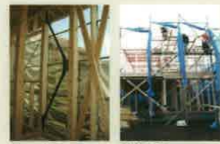
制震ブレースによる安心な暮らし 熟練の職人による丁寧な施工
