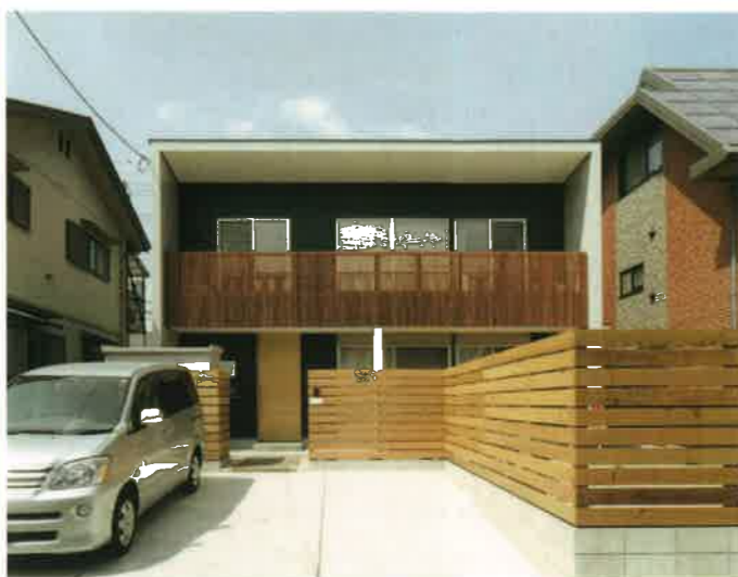
南側に張り出した庇とベランダで強い日射を遮り、快適な住環境を生み出す。余計な装飾等になるべく抑え、価格を高くすることなくデザイン性と耐震・省エネ性を追求（LCハウス施工例）
