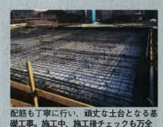
配筋も丁寧に、頑丈な土台となる基礎工事。施工中、施工後チェックも万全
